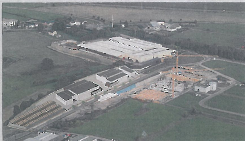
Kiowatt (Fotomontage, links) wird auf Roost neben Ameco (oben) und dem inzwischen fertiggestellten Datacenter (rechts) gebaut. Die Nähe zur Autobahn vereinfacht dabei die Versorgung mit Holz. (FOTO: LUXENERGIE)
